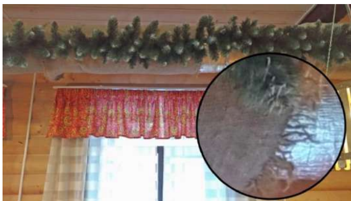
Рис. 2. Применение льняной мешочной ткани при декорировании воздуховода внутри помещения общественного питания
